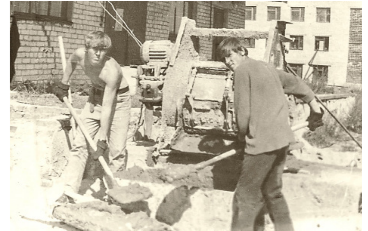
■ В СТРОЙОТЯДЕ «ЮНОСТЬ»
