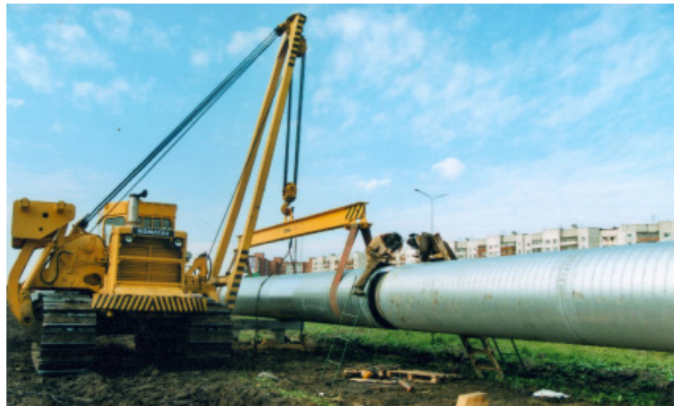
■ СТРОИТЕЛЬСТВО НЕФТЕПРОВОДА ВАНКОР-ПУРПЕ ИЗ ТРУБ ЗАВОДСКОЙ ТЕПЛОГИДРОИЗОЛЯЦИИ
